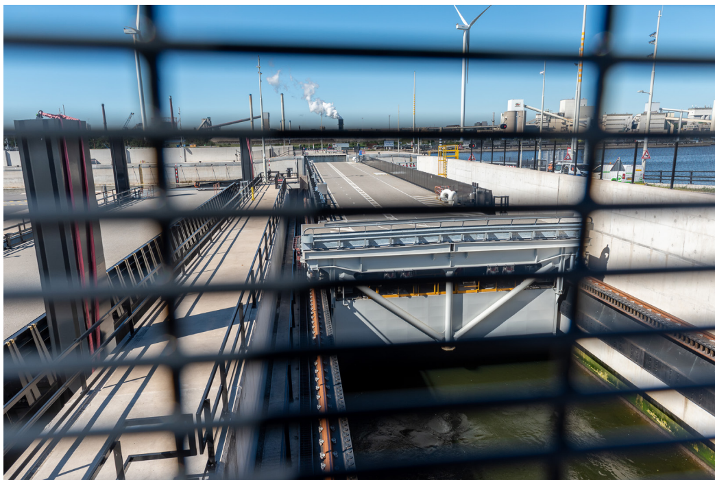
Zeesluis IJmuiden / foto: Rob Kluitenberg
